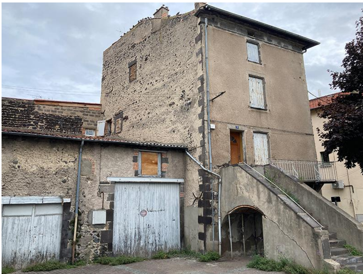
Maison avant démolition en 2022 avec son « ramaclé » en maçonnerie.
