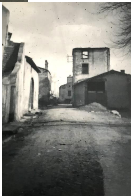
Le moulin après l'incendie
