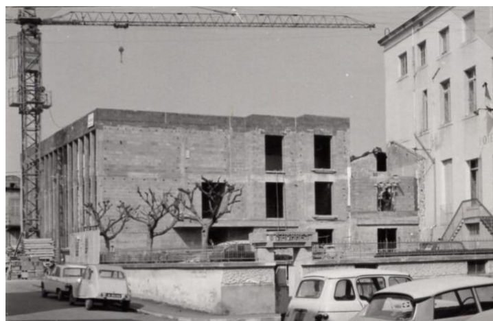
Avancement des travaux en avril 1974 (Cliché Marion).
