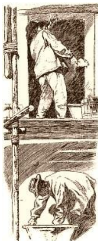
Maçons sur un échafaudage
