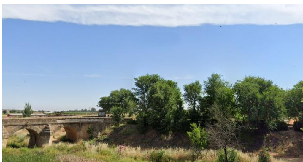
Le pont sur la rivière Albuera
