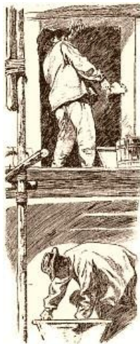
Maçons sur un échafaudage
